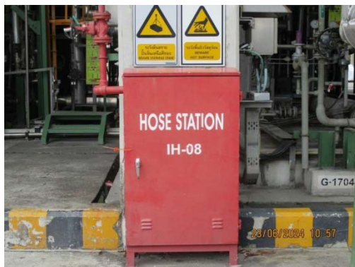
รูปที่ 55 Standpipe and Fire Hose Cabinet
