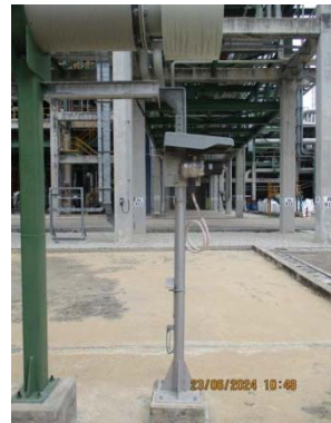
รูปที่ 36 Gas Detector บริเวณหน่วย RTO
