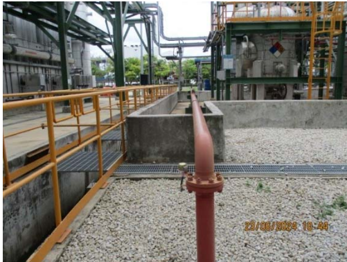
รูปที่ 65 ระบบม่านน้ำดับเพลิงบริเวณหน่วย RTO
