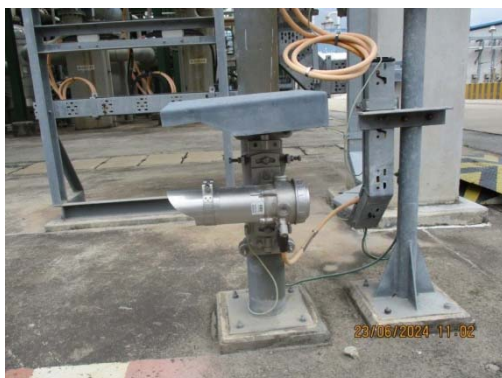
รูปที่ 51 Flame Detector
