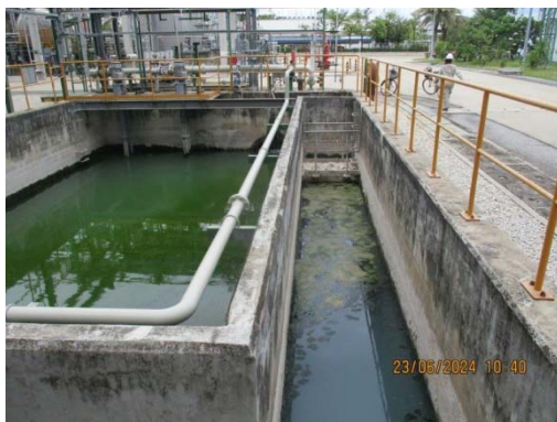
รูปที่ 9 Oil Separator
