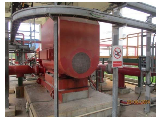
รูปที่ 58 Electric Fire Pump
