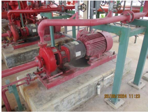
รูปที่ 59 Electric Jockey Pump
