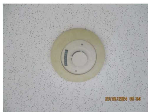
รูปที่ 52 Smoke/ Heat Detector
