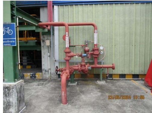
รูปที่ 42 Wet Alarm System
