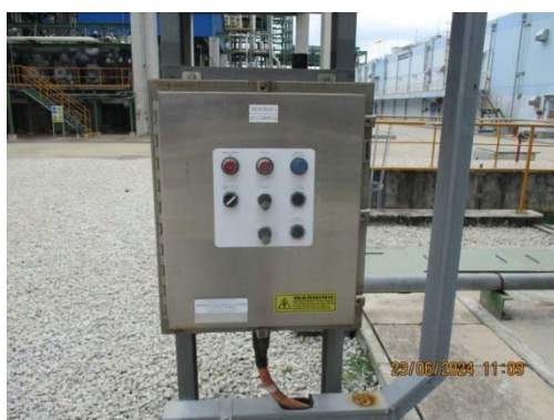
รูปที่ 45 Water Monitor Remote
