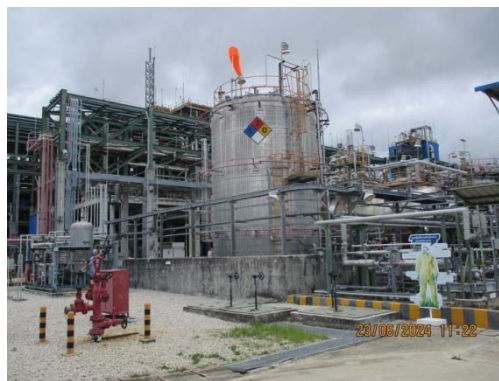
รูปที่ 34 คั่นคอนกรีตรอบถังกักเก็บ Isododecane
